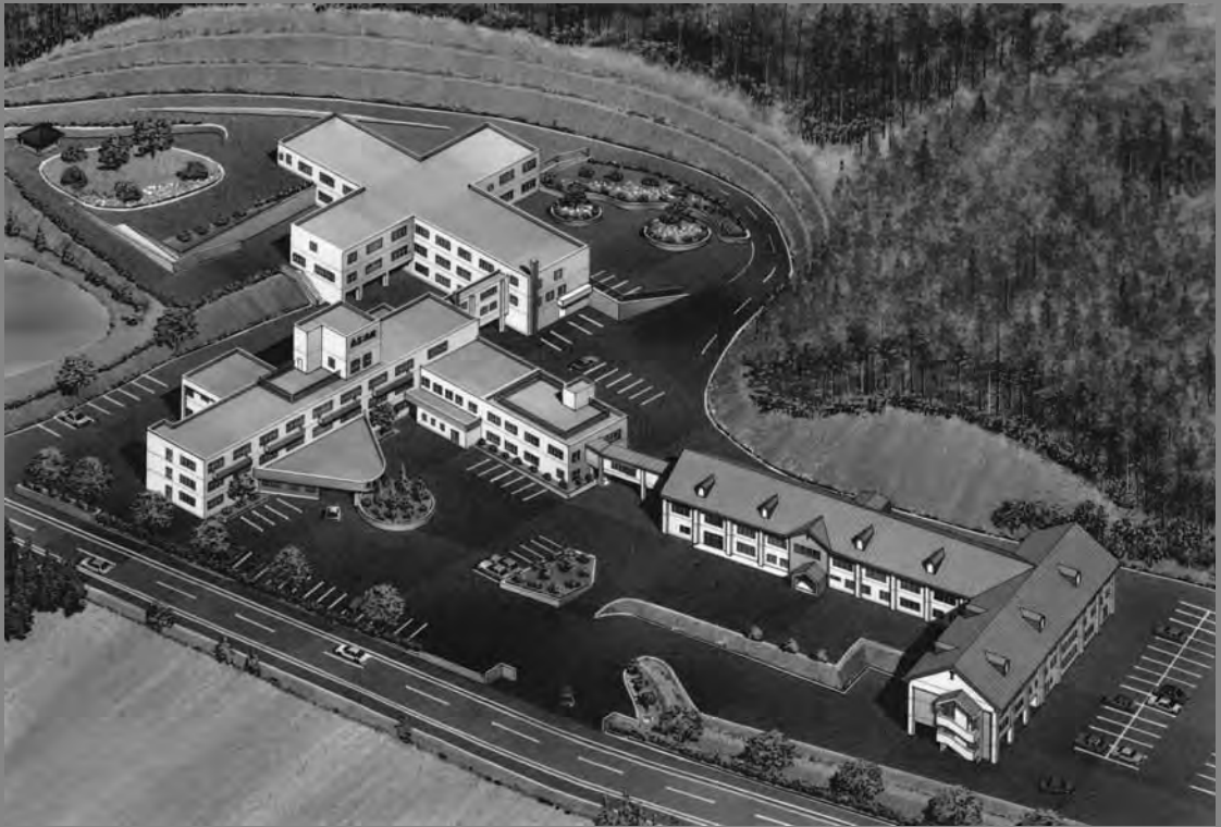
南昌病院・介護老人保健施設敬愛荘全景
